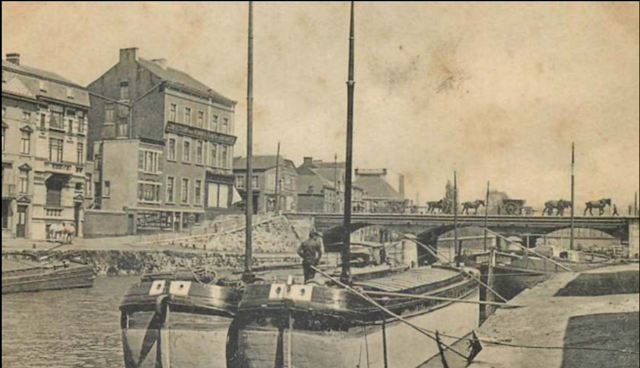
Marchienne-au Pont, le pont neuf 2018 © D. Belayew Marchienne-au Pont, le pont neuf v. 1900, carte postale Nels, Bruxelles
