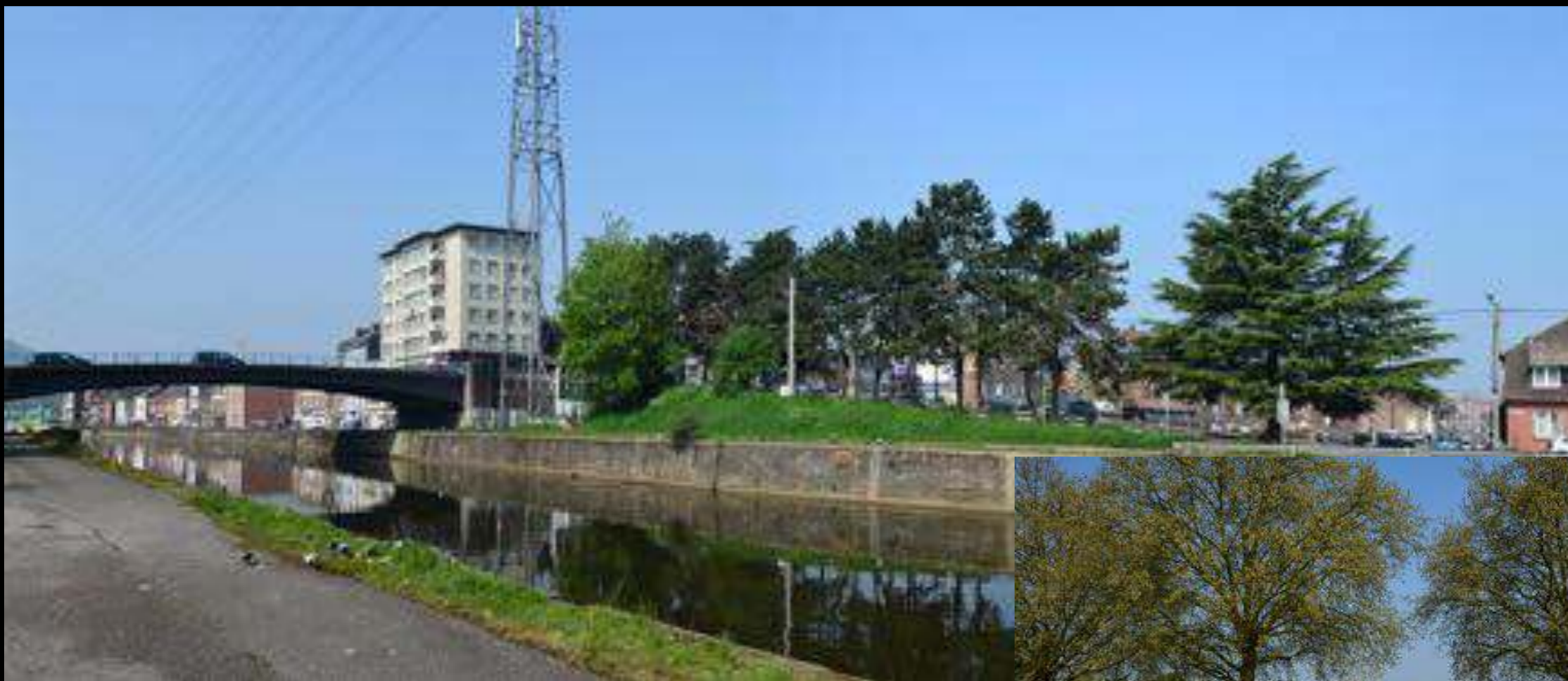
Marchienne-au-Pont, quai du Sud © D. Belayew, 2018
