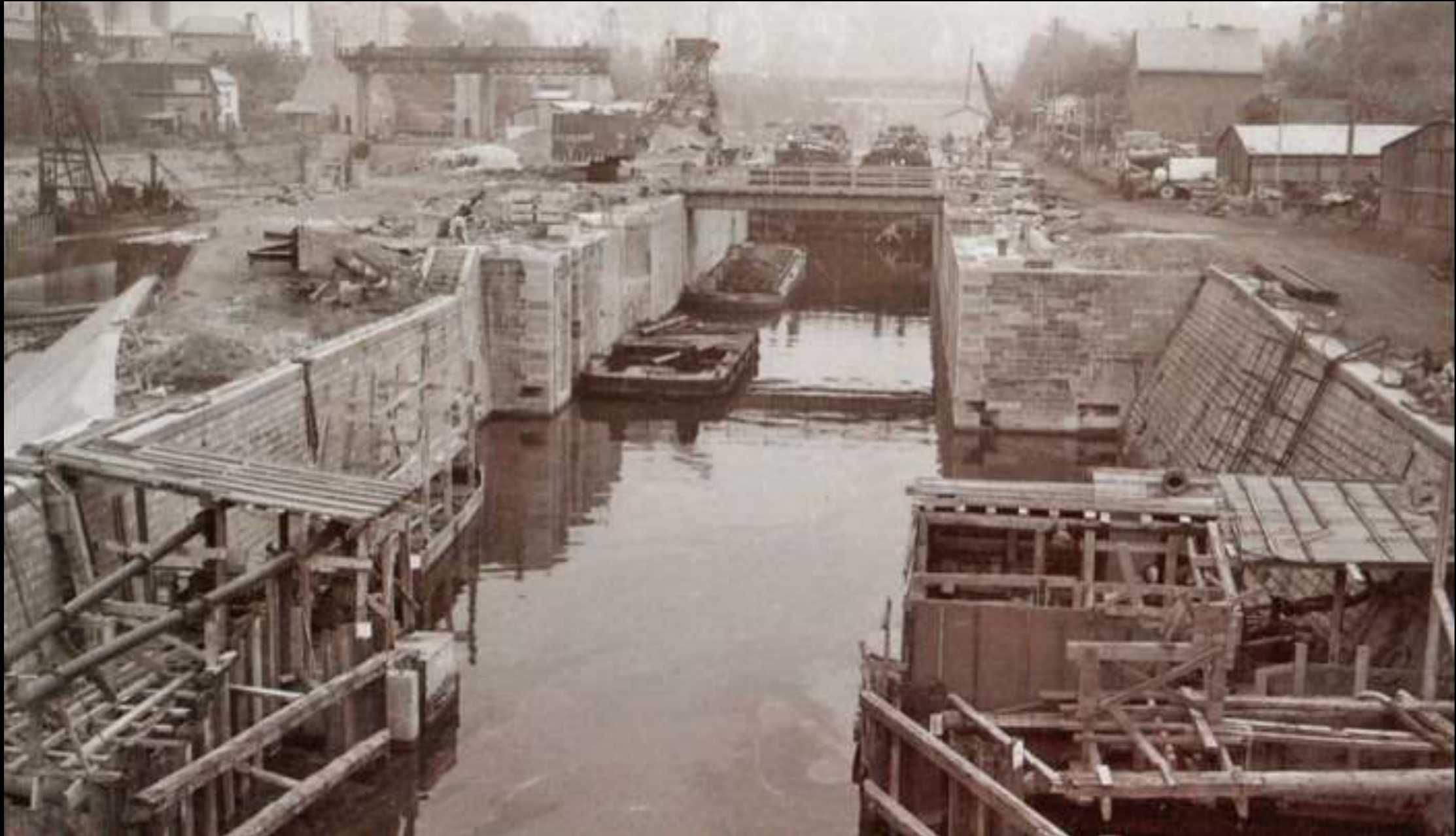
Monceau-sur-Sambre, construction de la nouvelle écluse, 1960, dans Colette Piérard, La Sambre, chronique d'une normalisation , 1997, Editions du MET, p.156
