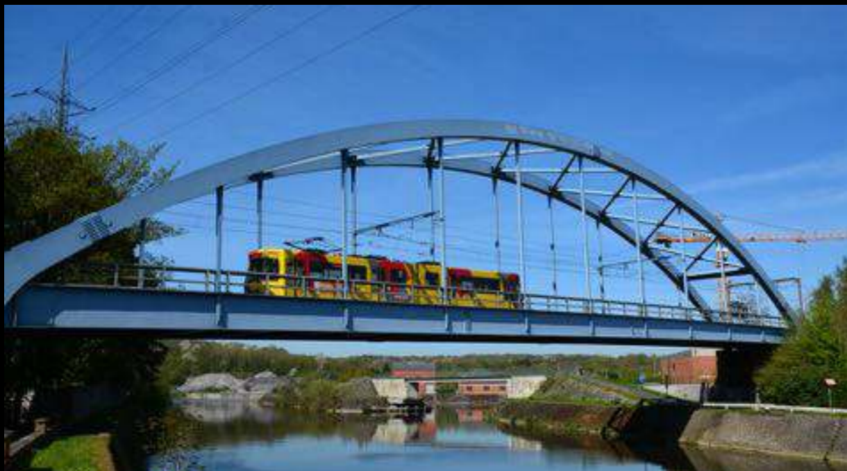
Marchienne-au-Pont, viaduc du pré-métro © D. Belayew 2018
