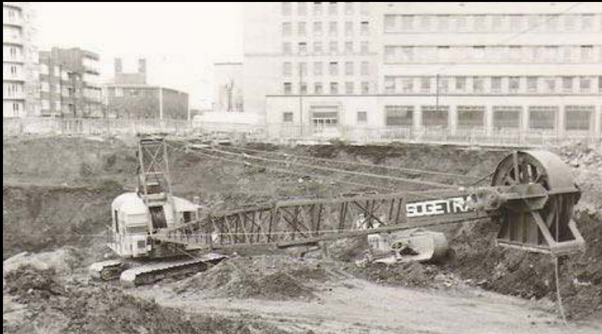
Charleroi, square Hiernaux, travaux du pré-métro v. 1970 http://www.passion-chantier.org/
