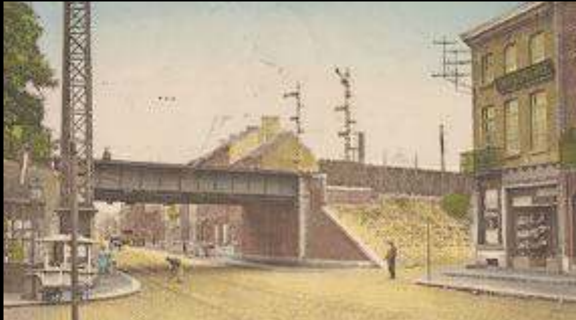
Marchienne-au-Pont, le pont du chemin de fer au-dessus de la route de Mons, http://charleroiipaysnoir.blogspot.be
