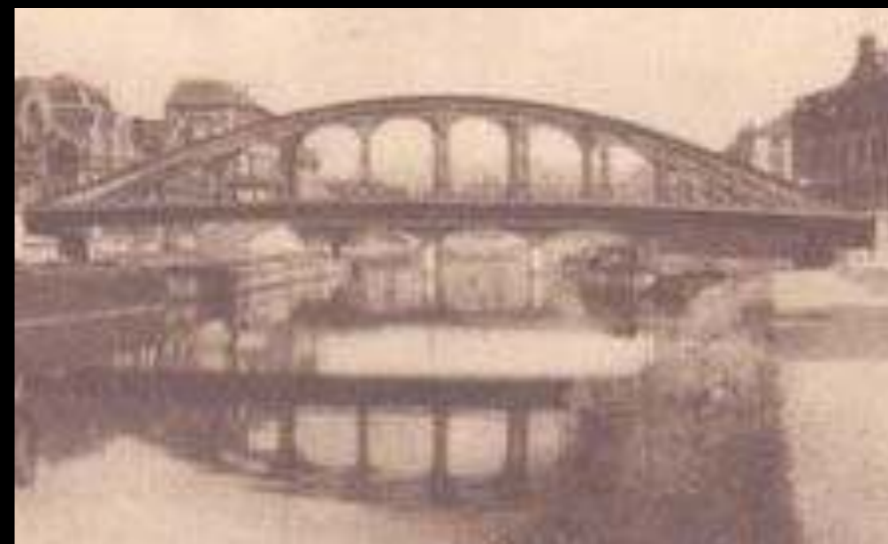
Marchienne-au-Pont, le pont neuf avant 1940, http://users.telenet.be/karel.roose
