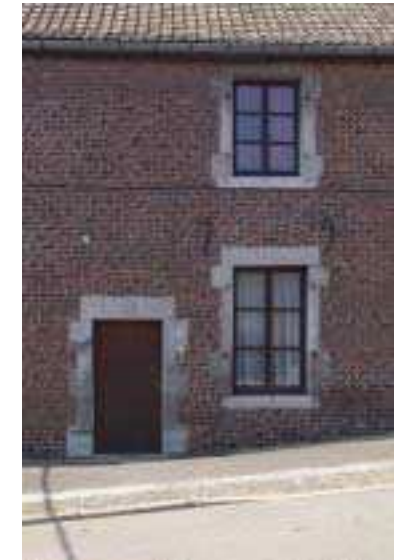
Quelques habitations de cette époque °
