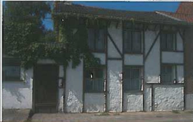
Maison à colombages, rue Try du Scouf.
