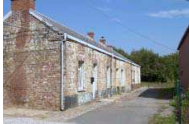
Bâties implantés perpendiculairement à la voirie de la rue P. Pastur.
