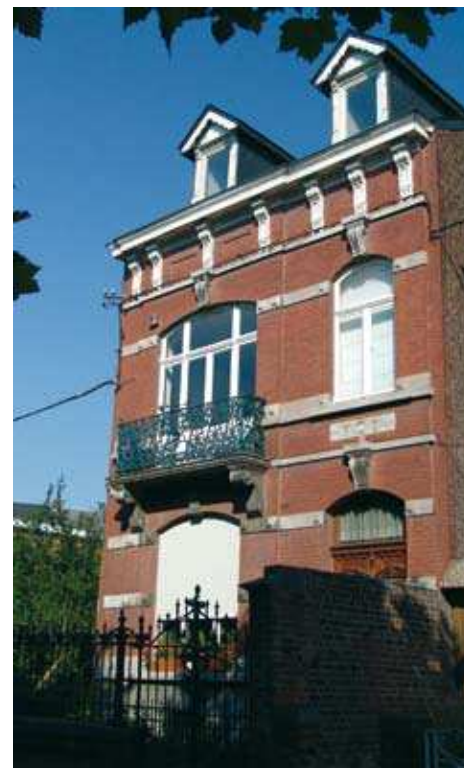
Rue J. Destrée, 51.
