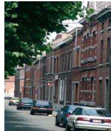
Rue J. Destrée.
