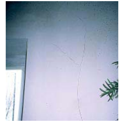
Moisissures, fissures... sont les tristes témoins d'un enduit extérieur au ciment dégradé.
