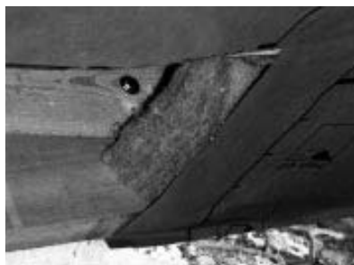
24 | UNE TOITURE PLATE EST UNE TOITURE PAR DÉFINITION ÉTANCHE : SON ÉTANCHEITÉ EST ASSURÉE PAR UNE MEMBRANE (PVC, BITUME, EPDM, CUIVRE OU ZINC). ELLE EST DONC IMPERMÉABLE À LA VAPEUR D'EAU.
