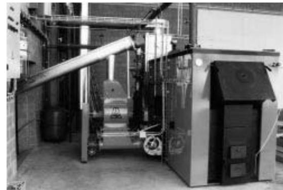
Pour se chauffer avec des copeaux de bois, il faut un silo à copeaux, un dispositif d'entraînement des copeaux (une vis sans fin), une chaudière et un conduit de fumée.
