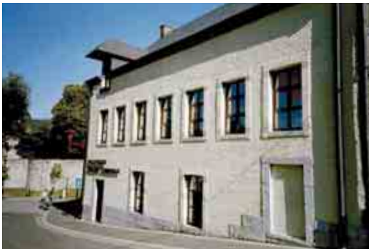
Après un nettoyage en douceur, un badigeon de chaux a été appliqué
