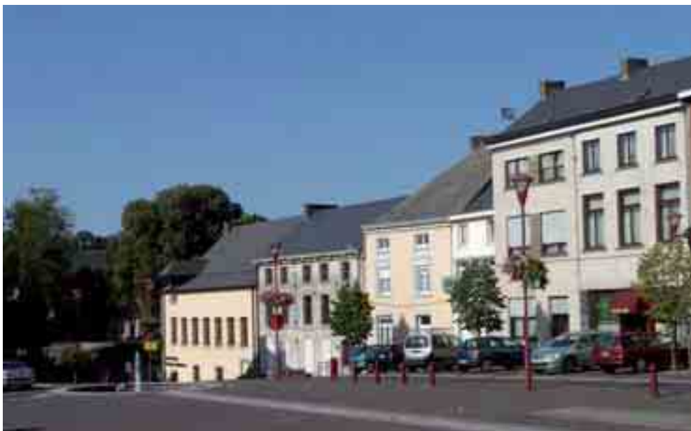
Fontaine-l'Évêque, place de la Wallonie rénovée
