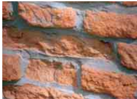
Détérioration des briques par un sablage non contrôlé ou l'arrachage d'un enduit
