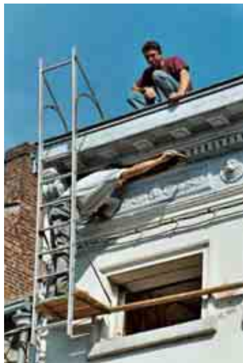
Le savoir-faire des artisans-stucateurs : ici la réfection de moulures enduites
