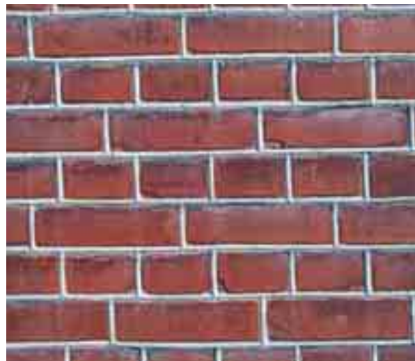
De meilleure qualité, les briques industrielles, plus résistantes aux intempéries et mieux appareillées, étaient destinées à rester apparentes
