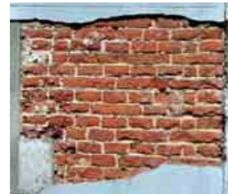
Détérioration des briques par un sablage non contrôlé ou l'arrachage d'un enduit
