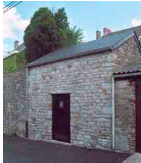
Limbourg, ruelle derrière la place Saint-Georges : cabine électrique intégrée dans l'alignement d'un mur en moellons.
