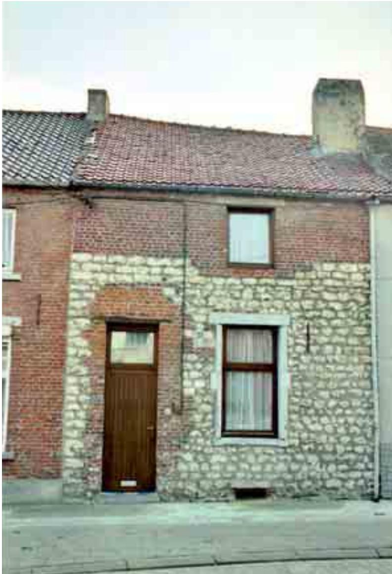
Façade dérochée (non conforme) : l'enduit arraché laisse apparaître des matériaux hétéroclites et des transformations
