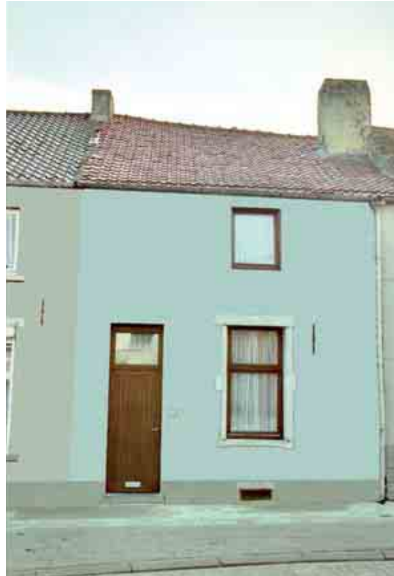
Façade enduite (simulation) (conforme) : l'enduit homogénéise la façade en camouflant les matériaux disparates
