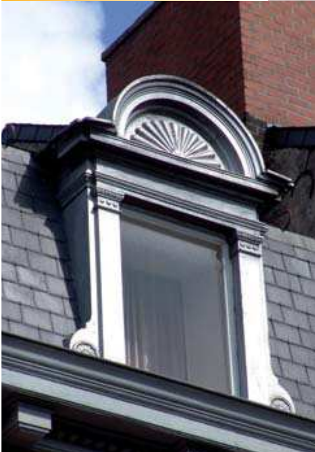
La lucarne habillée de zinc prend également une forme arrondie et se voit agrémentée d'un œil-de-bœuf.
