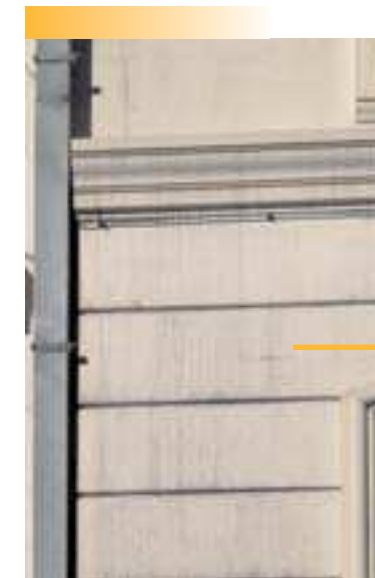
Restauration de l'enduit existant
