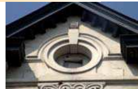
Les fines moulurations de l'enduit
