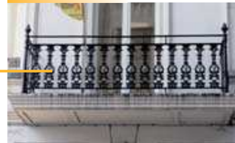
Conservation du petit patrimoine
