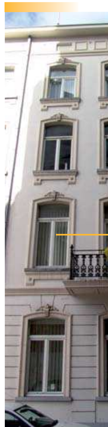
Restructuration des travées
