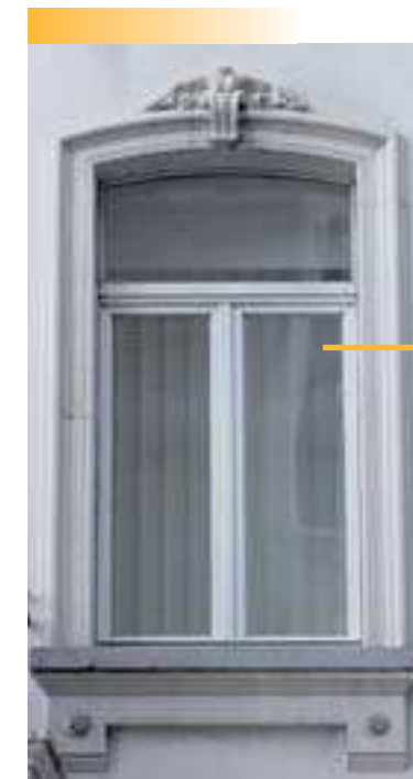
Conservation des menuiseries
