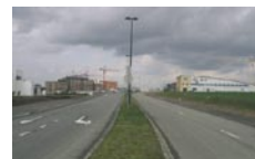
La situation avant aménagements.
