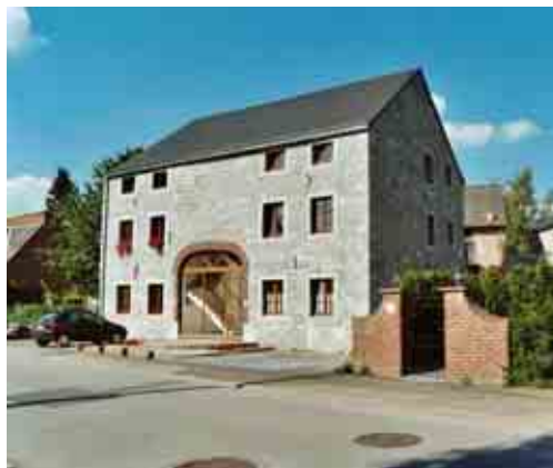
Etat actuel après rénovation
