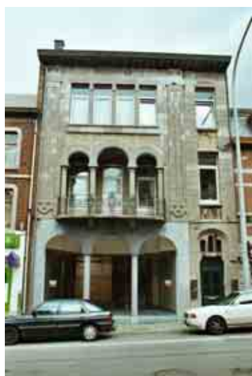
Etat après travaux
