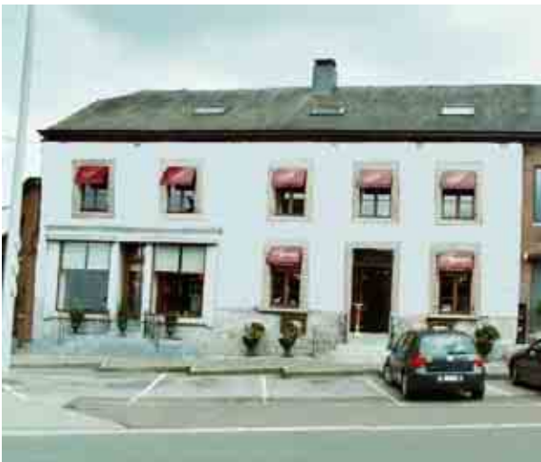
Simulation : pose d'un enduit sur la façade
