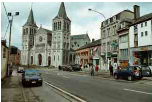
Etat actuel : un tronçon déstructuré de la rue de Behogne
