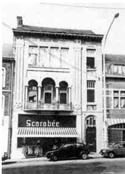
Etat avant travaux
