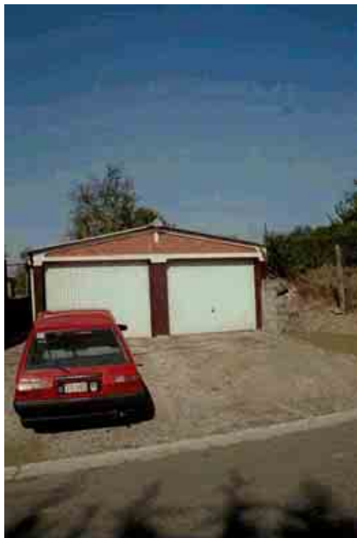
Mauvais exemple de construction de garage pris dans une autre localité
