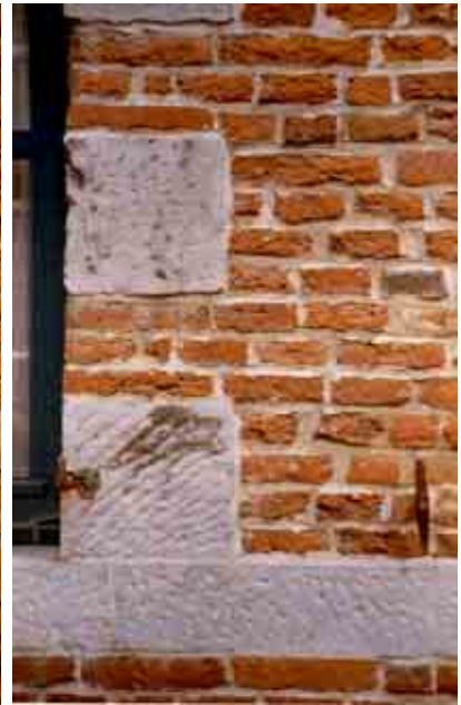
Ici, la pierre a été piquetée lors du placement de l'enduit pour favoriser son accrochage. Le dérochage rend visible ce piquetage inesthétique.
