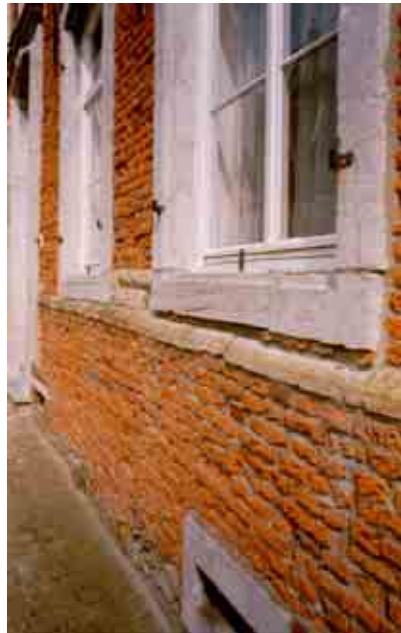
Façade décapée montrant des briques détériorées.
