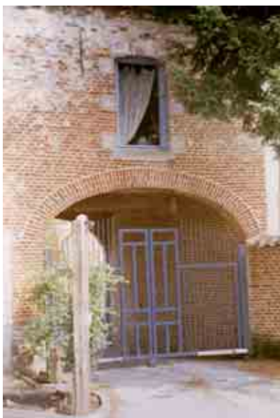
Couvent des Soeurs noires, cour intérieure
