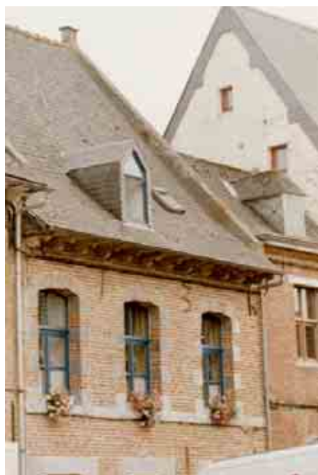
Rue du Château, n° 4
