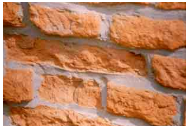
Dangereuse détérioration des briques décapées...
