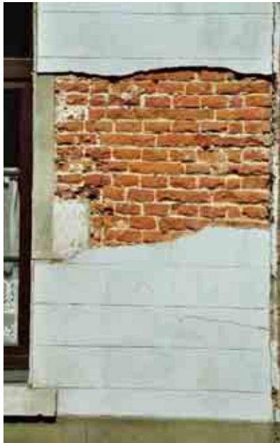
Façade en cours de dérochage montrant l'arrachage de la surface des briques
