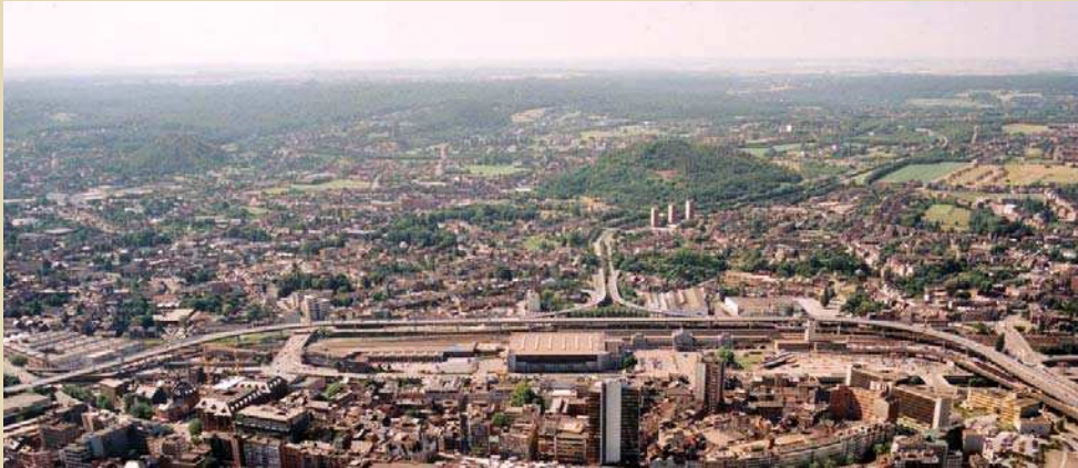
Imposante masse du terril des Hiercheuses dans le paysage du Sud de Charleroi
